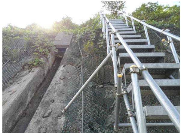
수직도수로, 점검계단 전경
