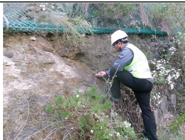
절리면 경사/경사방향 측정
